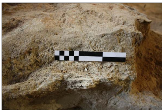
Fotografia 49. Detall regruix de calç parets interiors UE178.
