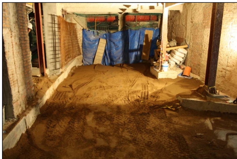
Fotografia 58. Protecció estructures documentades amb capa de sauló.
