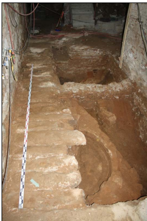
Fotografia 53. Claveguera general finca s. XIX UE209 feta amb grans lloses de pedra.
