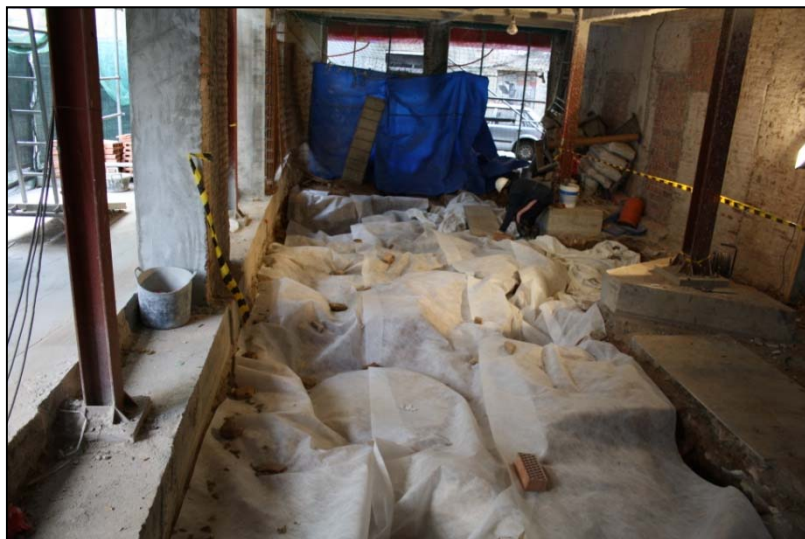
Fotografia 57. Cobriment estructures amb geotèxtil.
